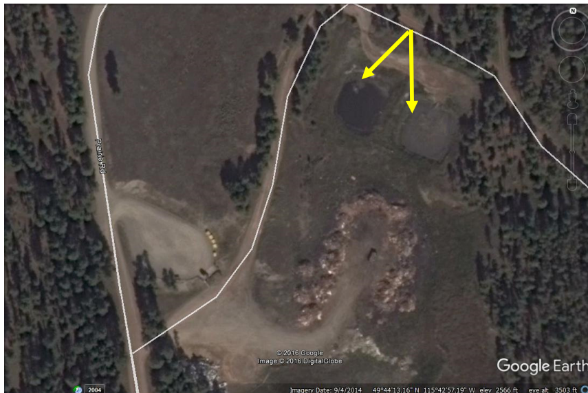
Fig. 2. Wasa Septage Treatment Site
